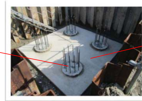
歩道橋(南北接続デッキ)を支える基礎工事の状況
